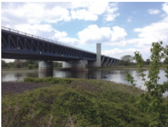
Kanalbrücke (© Helga Schühle)
